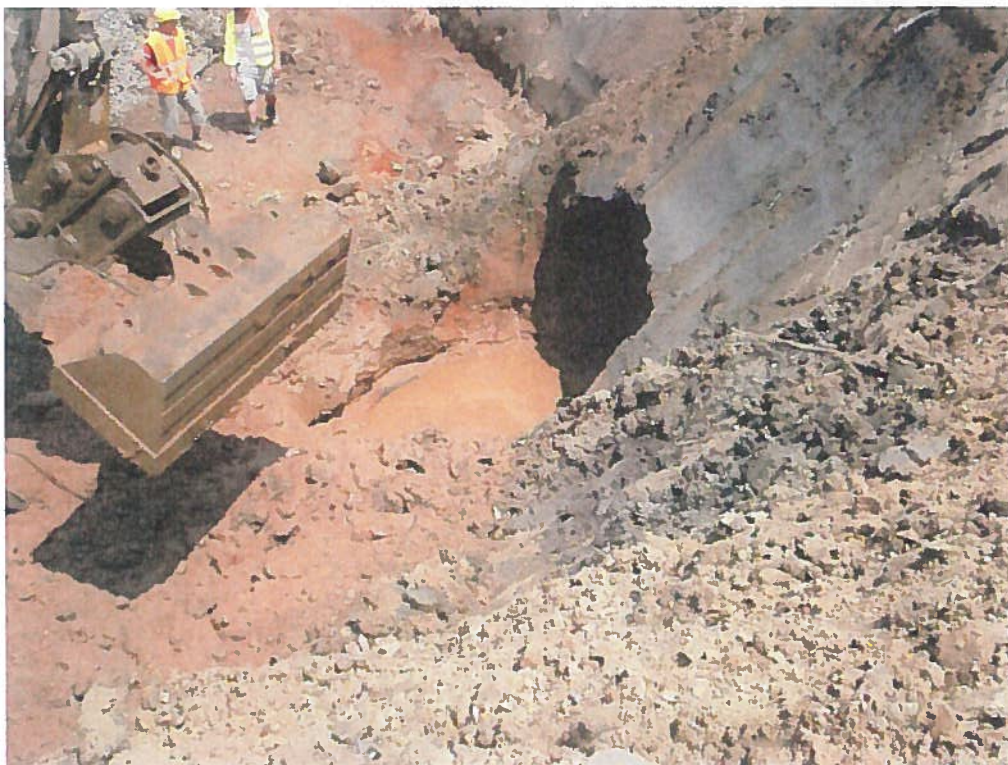
Výkop čerpací studny
