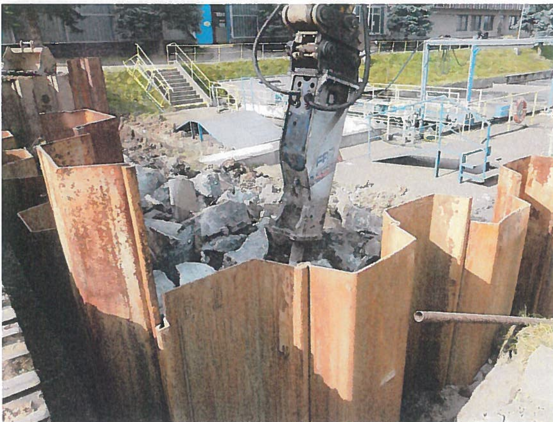
Bourání betonových bloků (jímka fugátů, rozdělovací objekt RO1)
