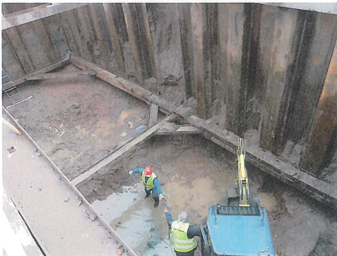
Pažení výkopové jámy – larsenová stěna
